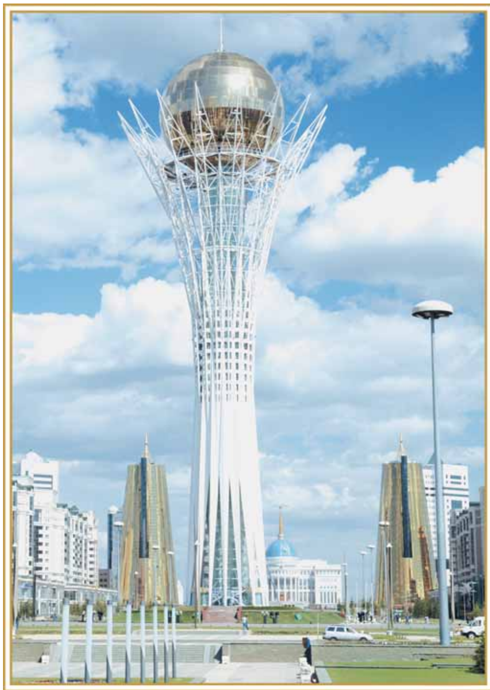
Монумент «Байтерек», строительство которого закончилось в августе 2002 г.
